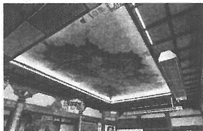
西江寺本堂(宇和島市)。天井画の周囲に額縁のようにゼロシーム「ジバングールド」を敷設
